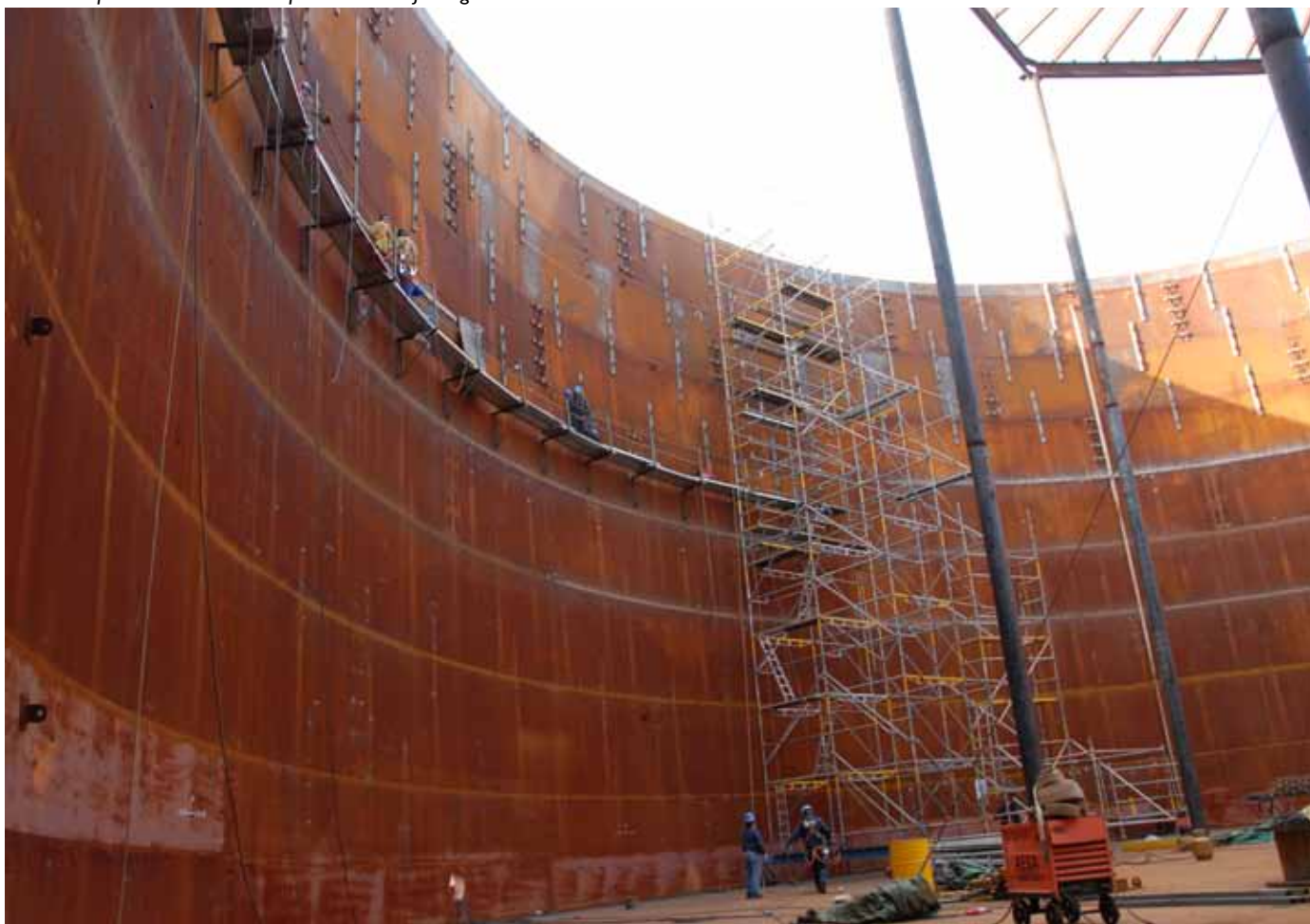
Nuevo tanque API de 30.000 m3 para almacenaje de gasoil
