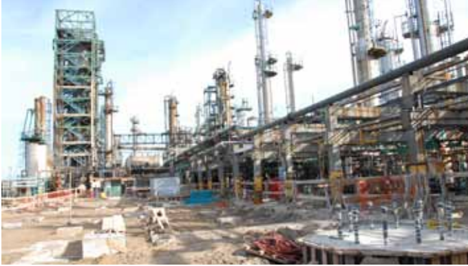
Trabajos en fundaciones para nueva planta de hidrodesulfuración de naftas
